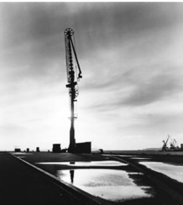
Grue de ravitaillement port de Brest
